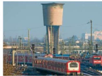
Der Wasserturm in Altona soll erhalten werden. FOTO: BERTOLD FABRICIUS
