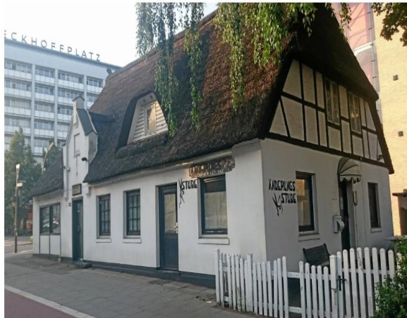
Lurups alte Kate zu Beginn der Renovierungsarbeiten. Die Tätigkeiten am ältesten Haus im Stadtteil laufen schon seit rund zwei Jahren (Archivbild).
