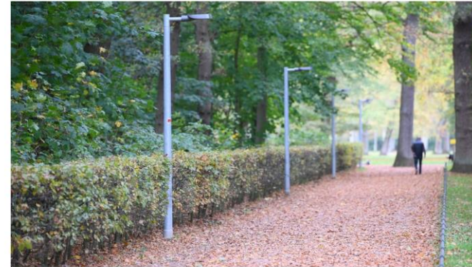
Die 48 Leuchten im Volkspark haben rund 400 000 Euro gekostet Foto: Jonas Walzberg
